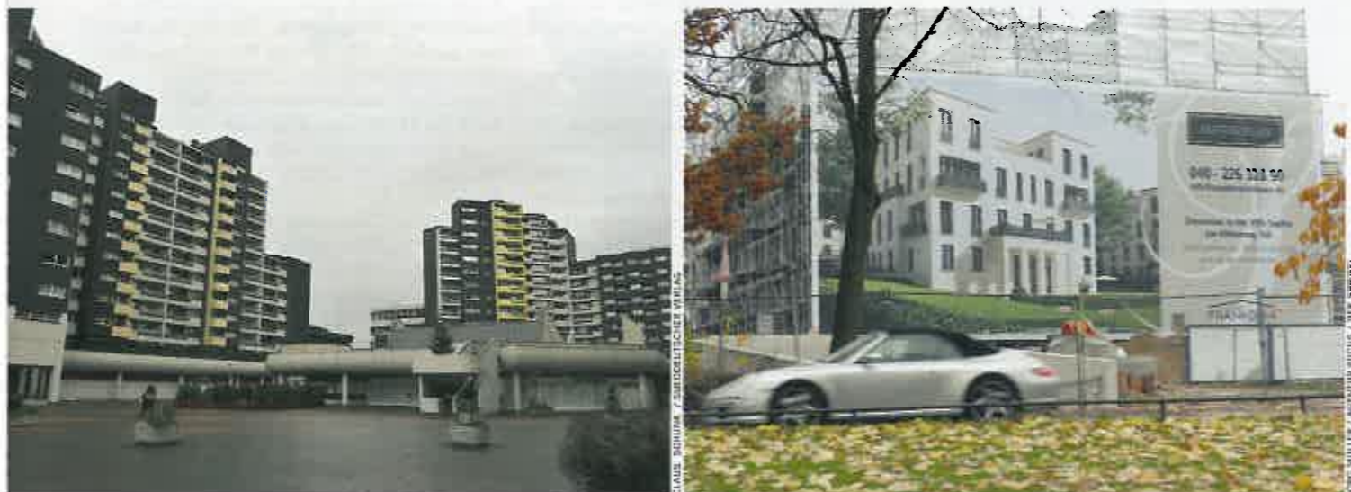
Hochhaussiedlung in München-Neuperlach, Luxusprojekt „Sophilenterrassen“ in Hamburg: Flucht in die Außenbezirke
